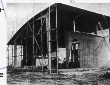
Die Betonrahmen sind mit Ziegelsteinen ausgemauert, die anderen Wände bilden große Glasfenster nach Entwürfen des Kirchenbauamesters Gottfried Böhm.
